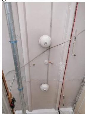
8. attēls. Pulvera dzēšanas sistēma apkures telpā.
