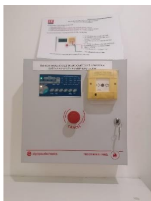
5. attēls. Aerosola dzēšanas sistēmas kontrolpanelis.
