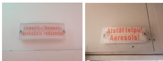
6. un 7. attēls. Zīmes "UZMANĪBU, AEROSOLS! IEROBEŽOTA REDZAMĪBA" un "ATSTĀT TELPU! AEROSOLS!"
