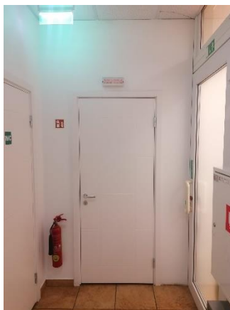
3. attēls. Objekta servera telpa
