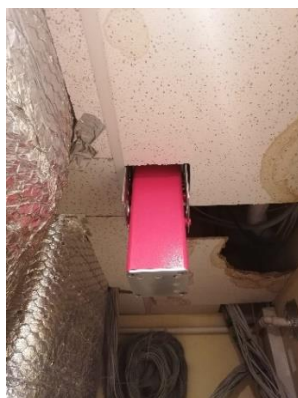
4. attēls. Aerosola ģenerators
