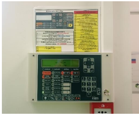
2. attēls. Automātiskās ugunsgrēka atklāšanas un trauksmes signalizācijas sistēmas atkārtotājpanelis.
